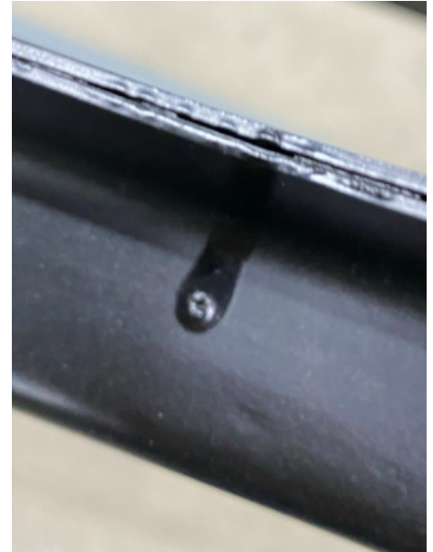
Afbeelding 1 - Leksporen van twee aan elkaar gemonteerde plaatdelen.
